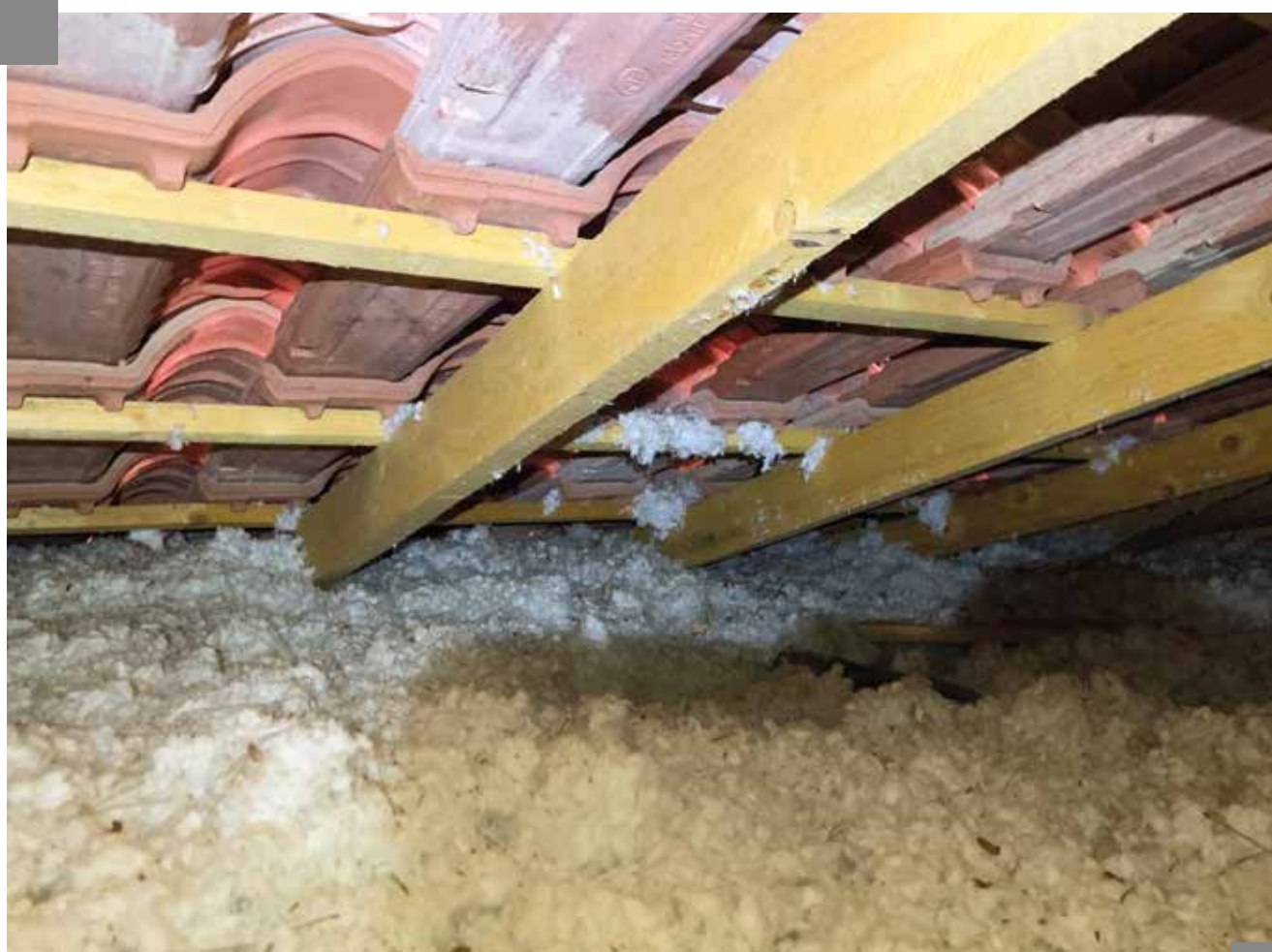
Isolation soufflée sur le plancher de combles. (Photo Alix BADO)
